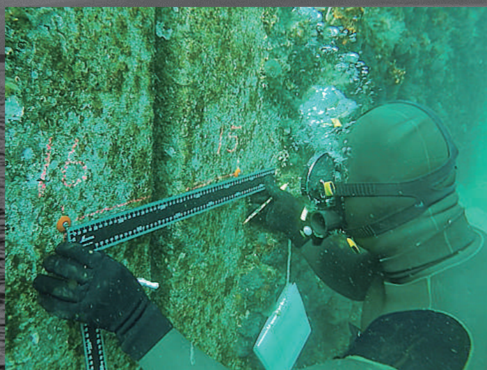
ケーソン目地移動量調査
